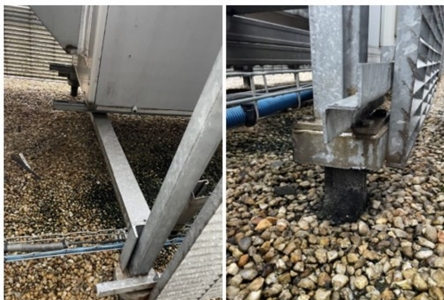
Figure 3 - Supportages et piètements de la centrale de traitement d'air existants
